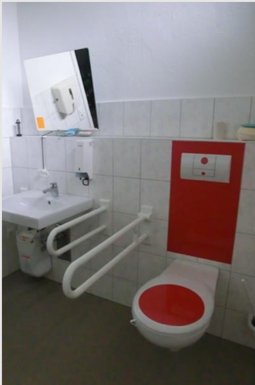
behindertengerechter Zugang zum Naturbadgebäude mit Schaffung eines behindertengerechten WC
