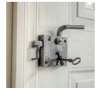
6. Das aufgearbeitete Kastenschloss wieder in der Tür
