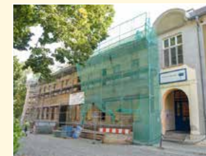
Das neue Schulzentrum am Kirchplatz im Entstehen
