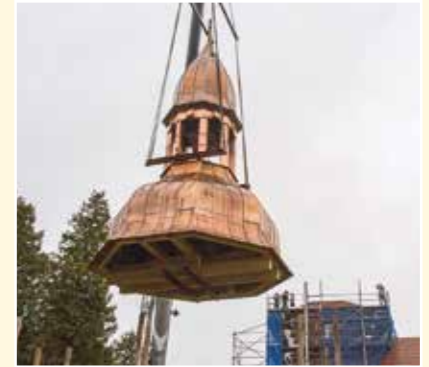
Feierliche Krönung des sanierten Kirchturms am 24. Oktober 2017 in Laubst
